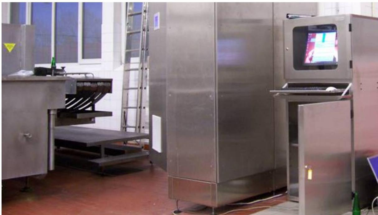
Obrázek 3.3: Silový rozvaděč s operátorským panelem a skříní s PC
