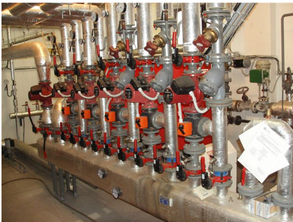
Obrázek 4.4: Rozdělovač se směřováním jednotlivých topných okruhů
